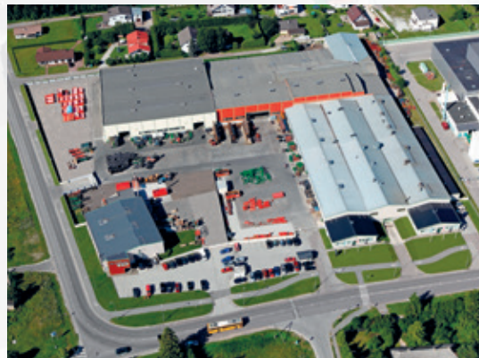
Fors MW og fabrikken vår er spesialutformet for korte serieproduksjoner. Fabrikken vår ligger i Saue, 15 km fra Tallinn, Estland. Produksjonsarealet består av 40 000 m 2 , hvorav 18 000 m 2 er under tak.
